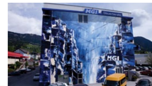
MGI Ennstal Steuerberatung Liezen: Von der gesichtslosen Hülle zur ausdrucksstarken Fassade mit einzigartigem Wiedererkennungsfaktor.
