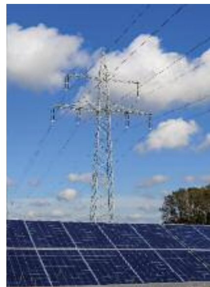
Strom, der nicht selbst verbraucht wird, kann in das Netz der EVN eingespeist werden.
